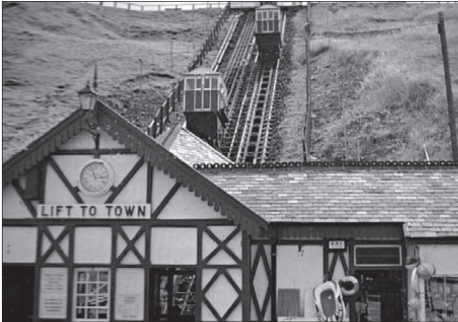
De Saltburn Trainlift werkt volgens de principes van de zwaartekracht
